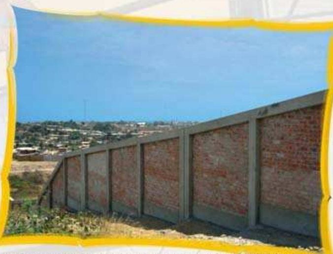
Culminación de cerco perimétrico que bordea los límites de la Ciudad Universitaria, antes invadida por ladrilleros.
