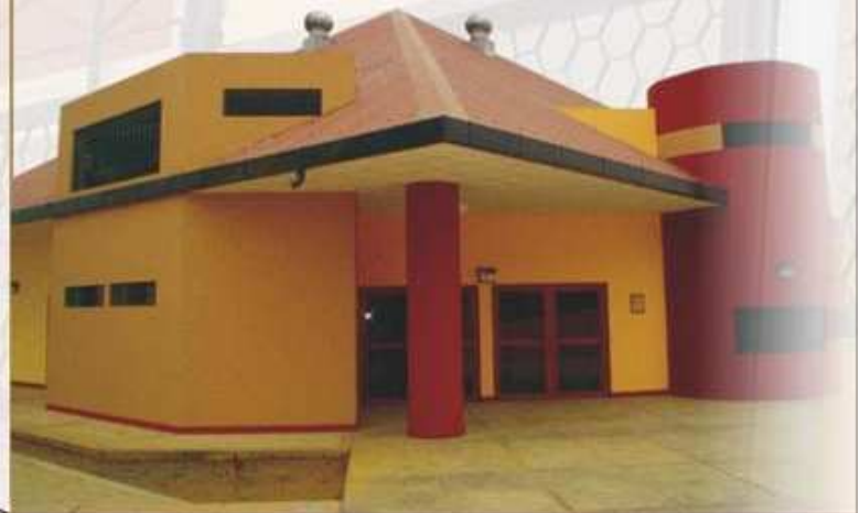
Mantenimiento general del Podium
