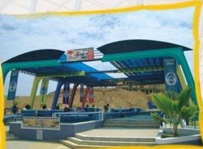
Techado de la Pileta
